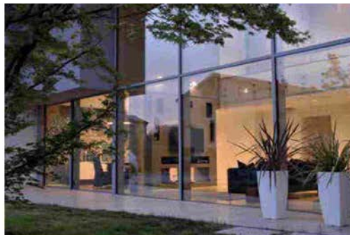
Villa realizzata con serramenti battenti 75 mm e scorrevoli ASE 67 Schuco, il particolare della foto rappresenta una facciata Schuco FWS 60
