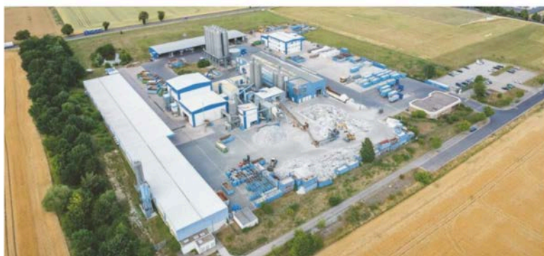
L'impianto di riciclo del PVC di Behringen
