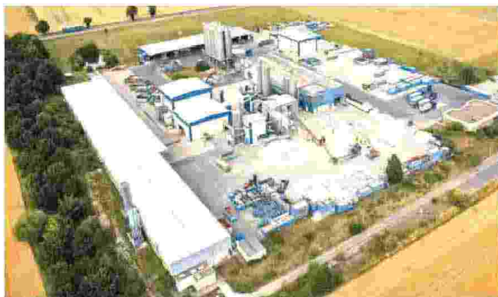
Stabilimento di riciclo Umwelttechnik di Behringen Germania
