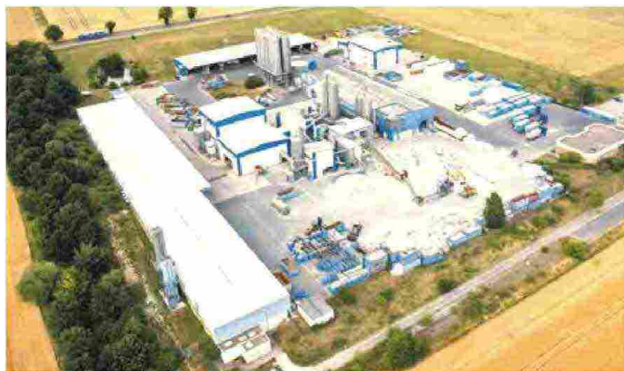
Stabilimento di riciclo Umwelttechnik di Behringertec Germania
